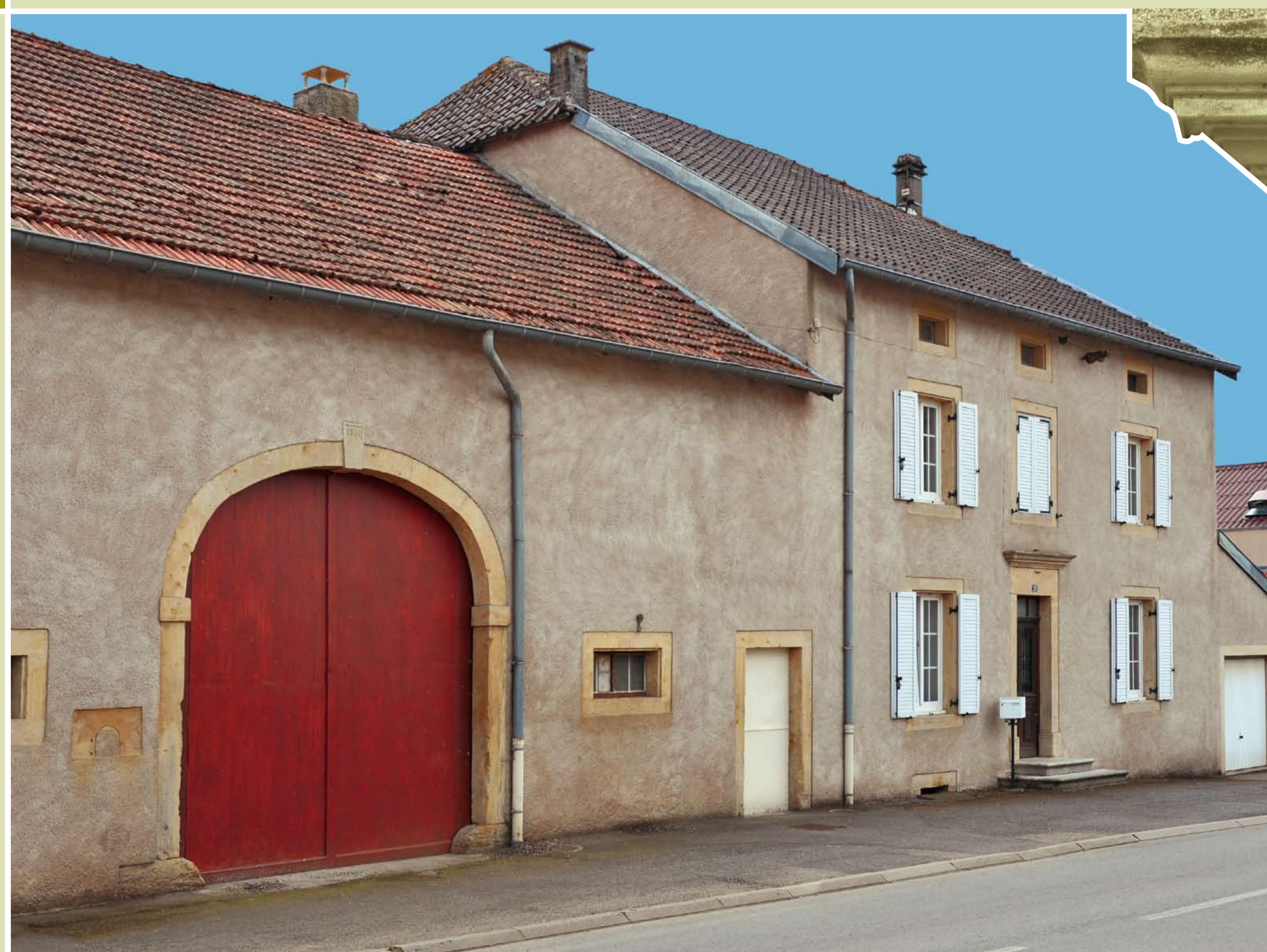
HAVANGE, ferme à trois travées
