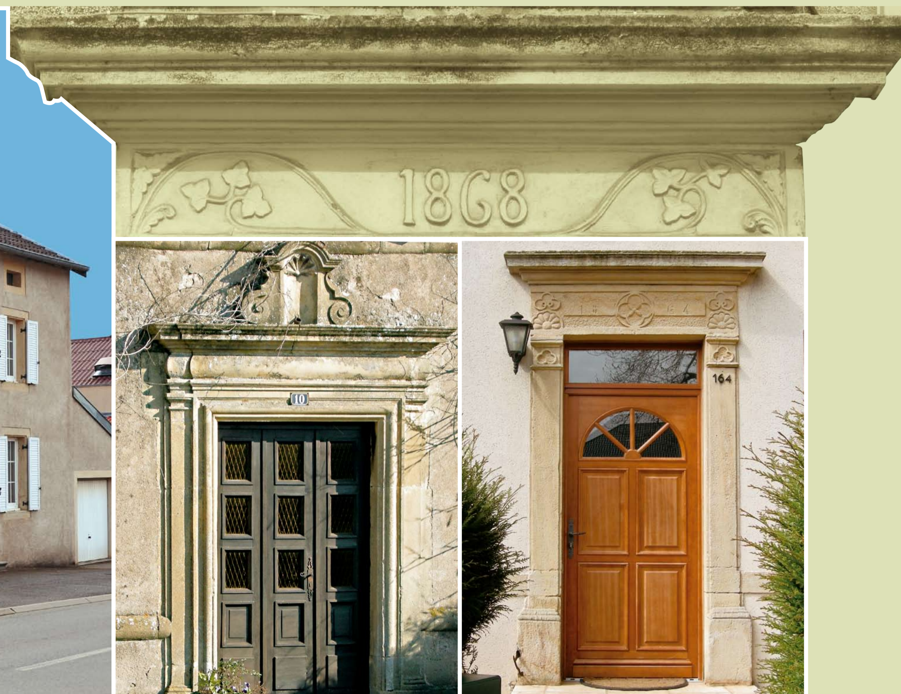
TRESSANGE, Ludelage, porte piétonne surmontée d'une niche à coquille vide
